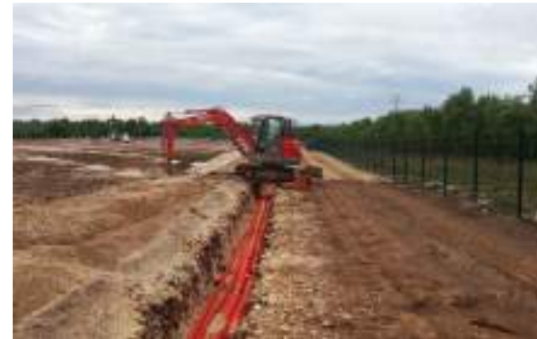
Figure 71 : Exemple d'enfouissement de câbles électriques
