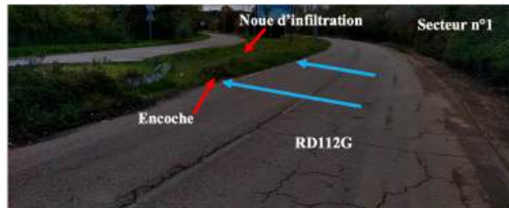
Figure 11 : Illustration photographique de la noue d'infiltration et des encoches, observées les 13 et 14 octobre 2021
