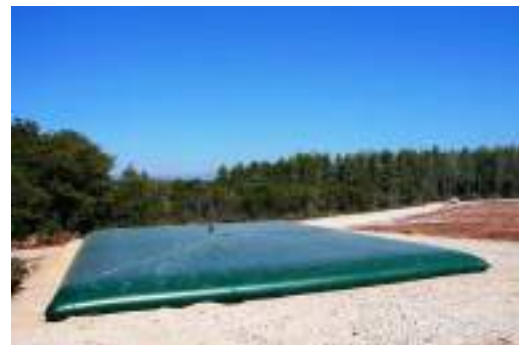
Figure 67 : Photographie d'une citerne
