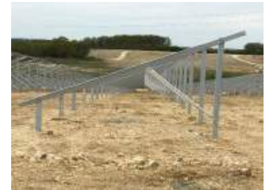
Figure 73 : Exemple d'une structure porteuse complète avant mise en place des panneaux
