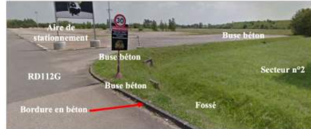
Figure 21 : Illustrations photographiques du fossé et des buses (Source : Google Maps)
