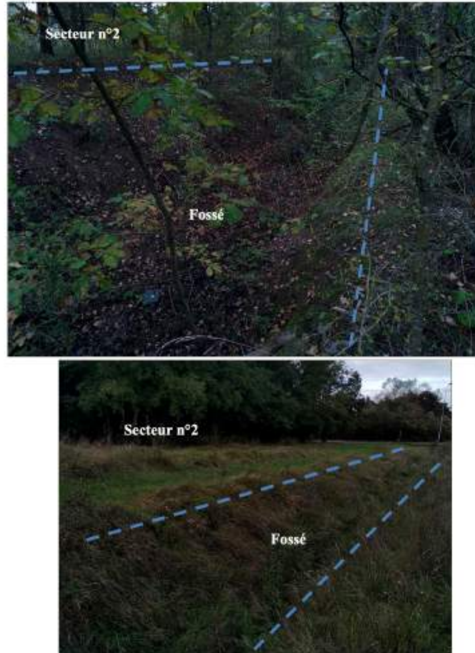
Figure 18 : Illustrations photographiques du fossé d'infiltration présent en bordure est du secteur n°2, observé les 13 et 14 octobre 2021
