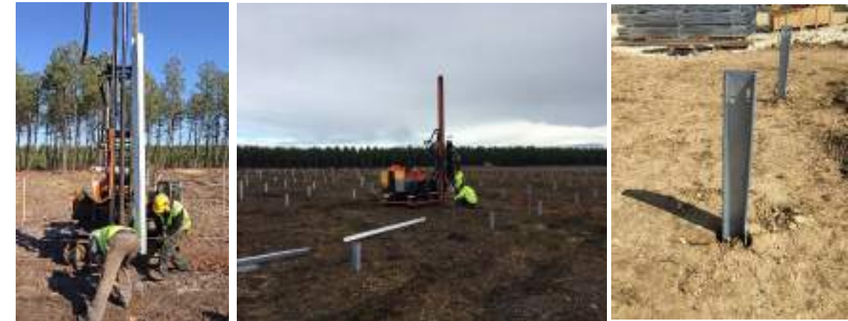
Figure 72 : Exemples de mise en place des pieux battus sur les chantiers URBASOLAR
