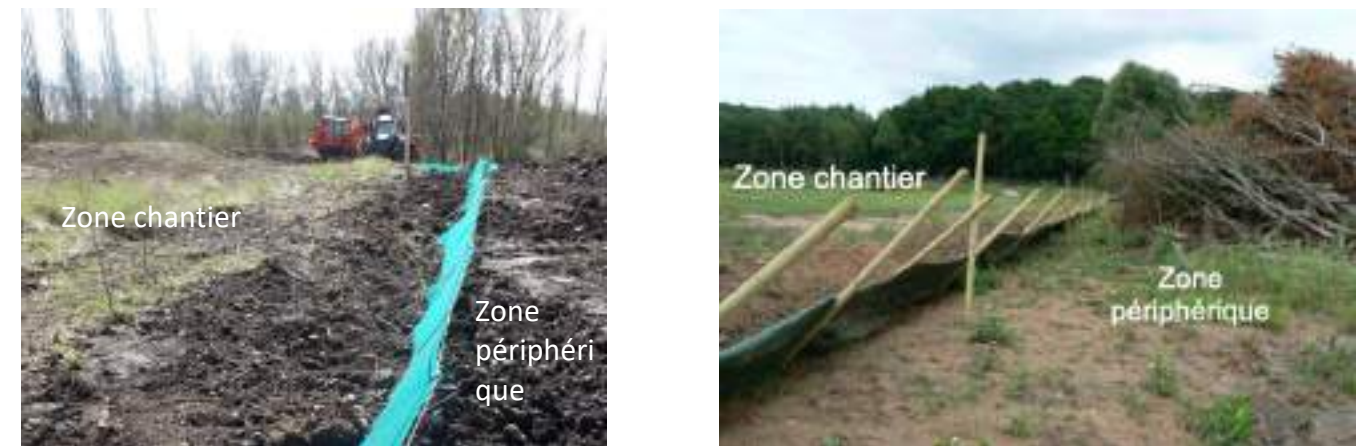
Exemples de bâches anti-intrusion vis-à-vis des amphibiens sur chantiers (Source : AdT)
