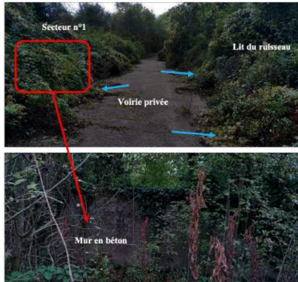
Figure 6 : Illustrations photographiques de la voirie privée et du mur en béton, observés le 13/10/2021
