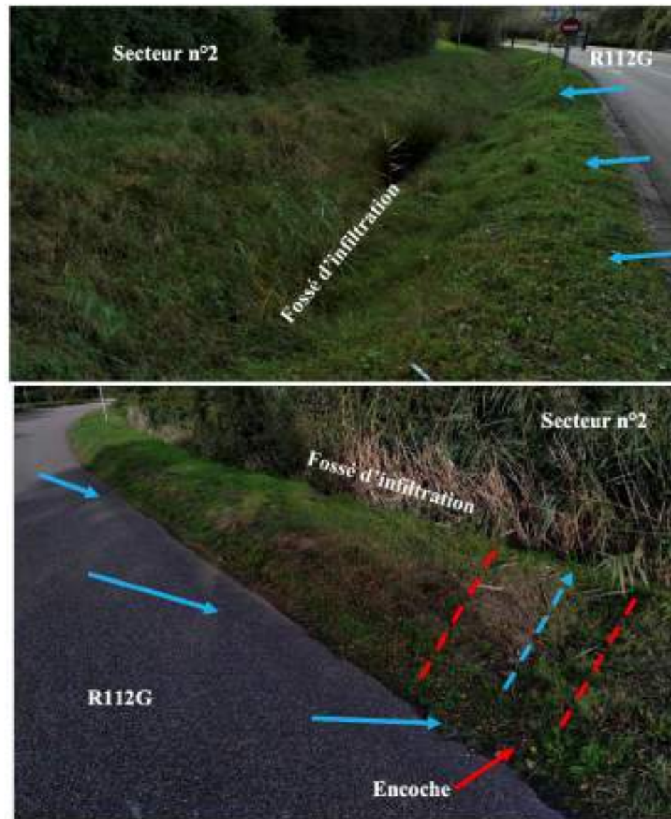
Figure 14 : Illustrations photographiques du fossé d'infiltration, observé les 13 et 14 octobre 2021
