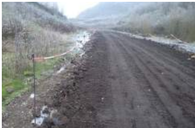
Exemple de balisage perméable temporaire sur un chantier (Source : AdT)
