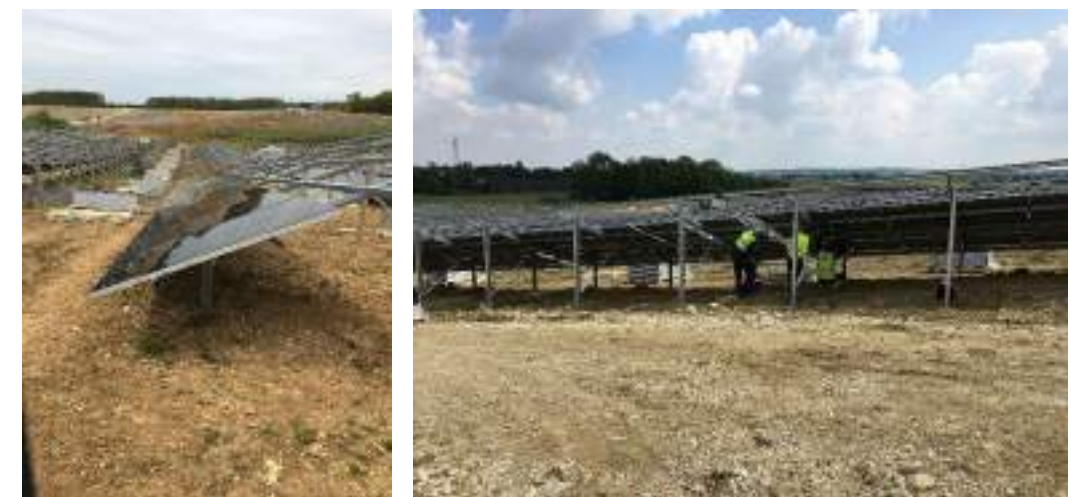
Figure 74 : Exemples de mise en place de panneaux sur les chantiers URBASOLAR
